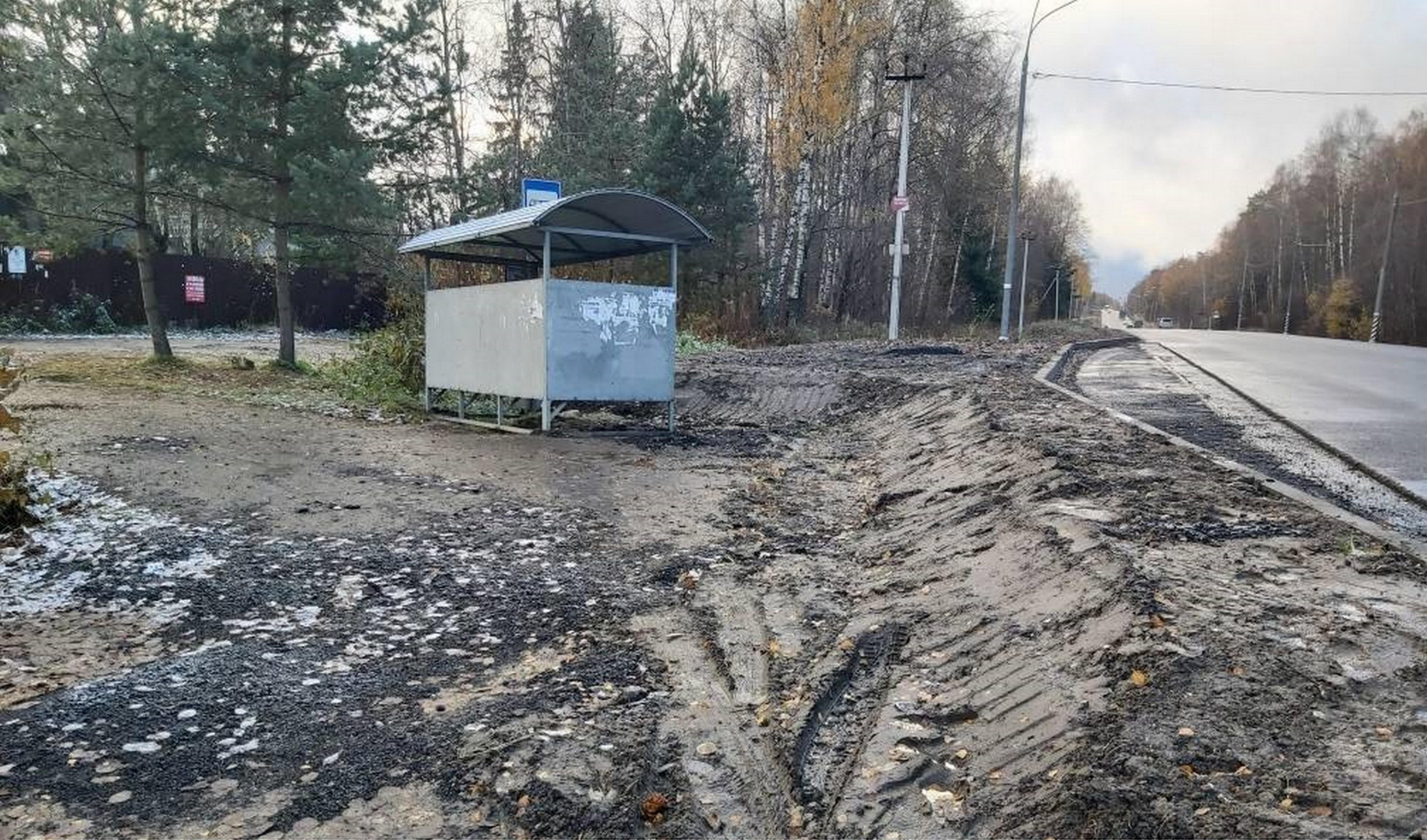
Слева - въезд в СНТ "Отдых", справа - трасса А108. После ремонта А108, высота трассы А108, выше, чем уровень въездной дороги в Снт "Отдых", более, чем на 65 см. Плюс, установлен бордюр. Ранее, высота полотна А108 и въездной дороги в СНТ "Отдых", были на одном уровне.
