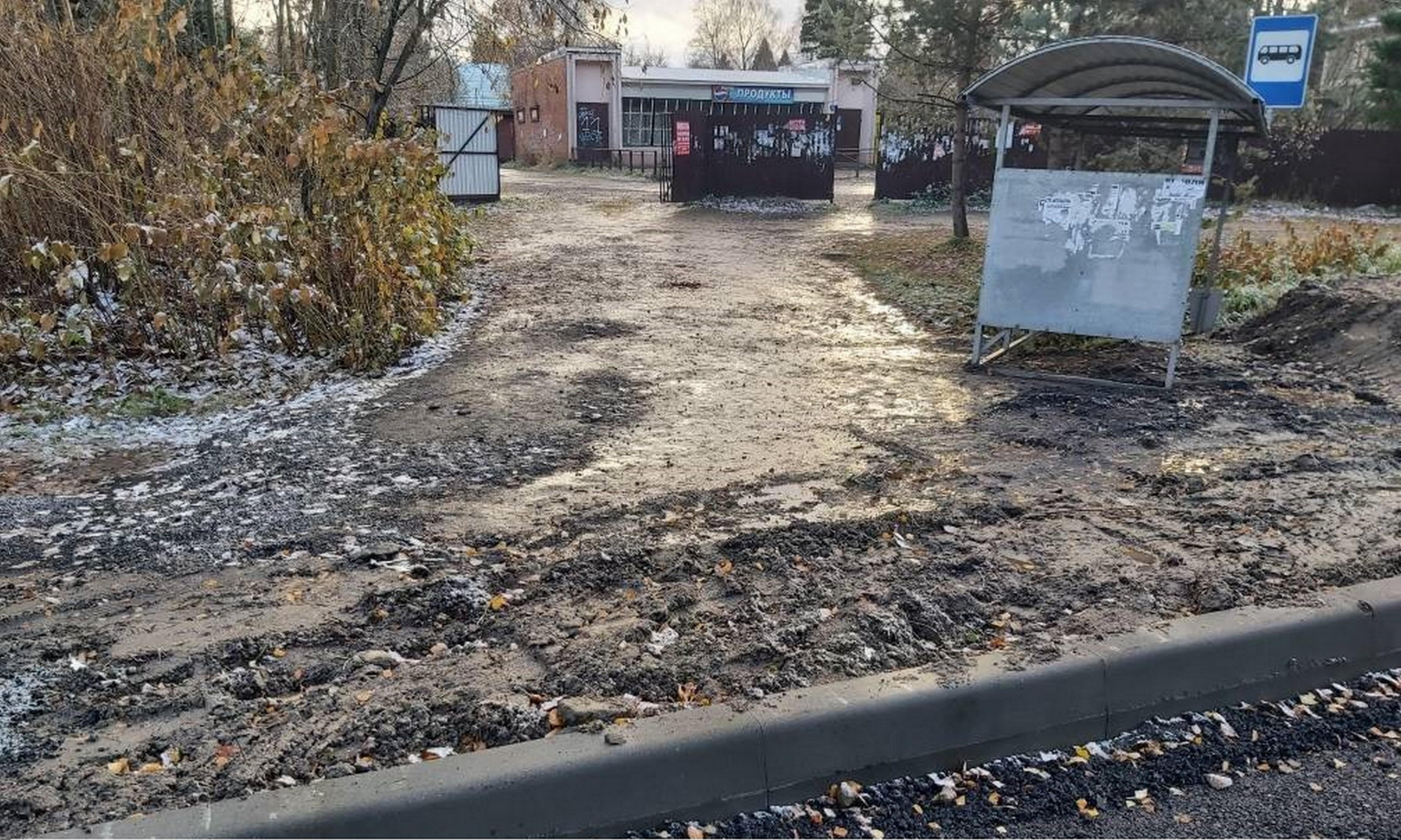
Вид с трассы А108 на въездную дорогу в СНТ "Отдых". Полотно трассы А108 поднято выше на более, чем 65 см и установлен бортик еще на + 30 см. Таким образом, въезд и выезд из СНТ заблокирован.
