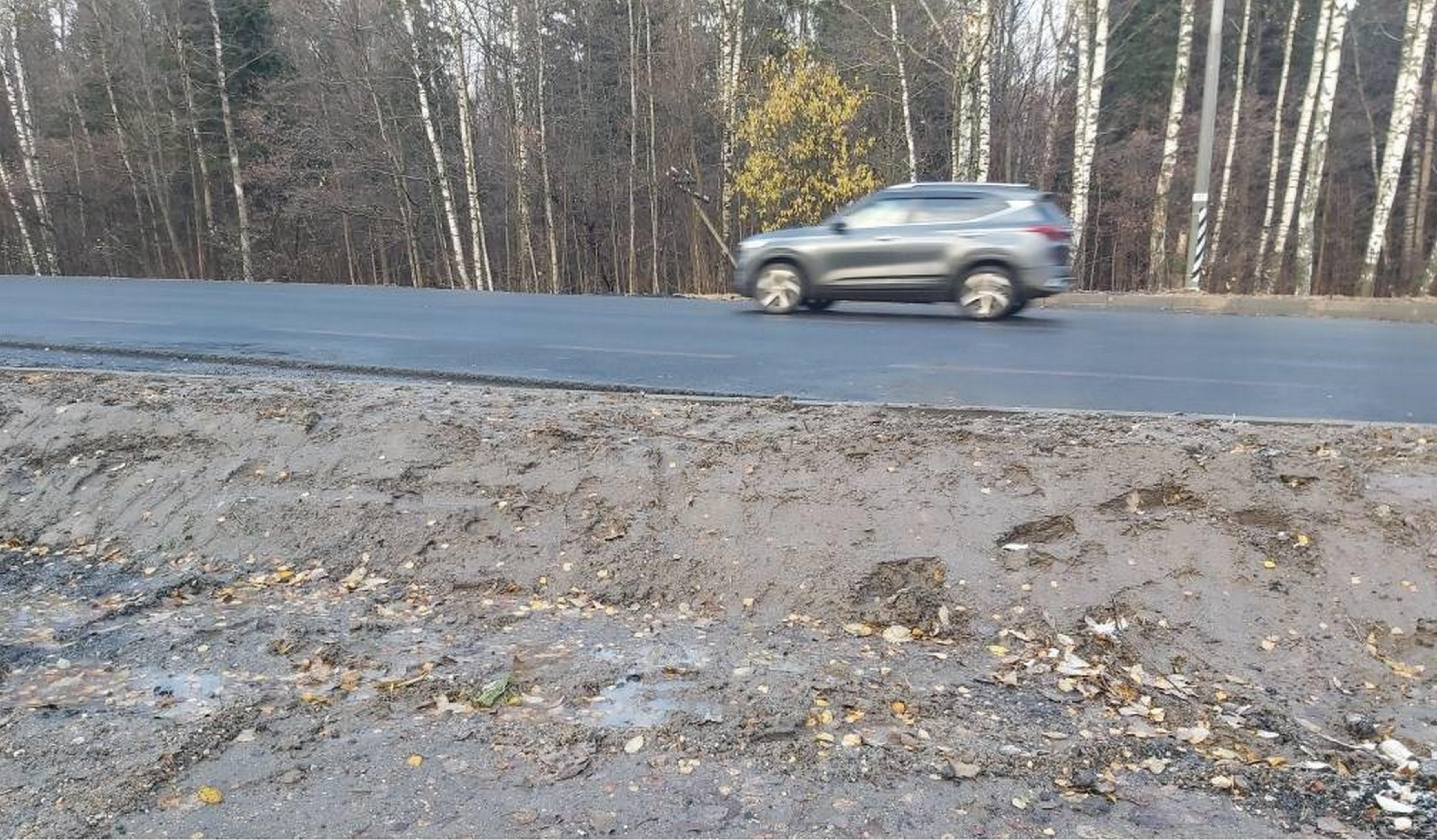
Вид на трассу А108 с въездна из СНТ "Отдых". Полотно трассы А108 поднято выше, чем 65 см и установлен бортик еще на + 30 см. Таким образом, въезд и выезд из СНТ заблокирован.
